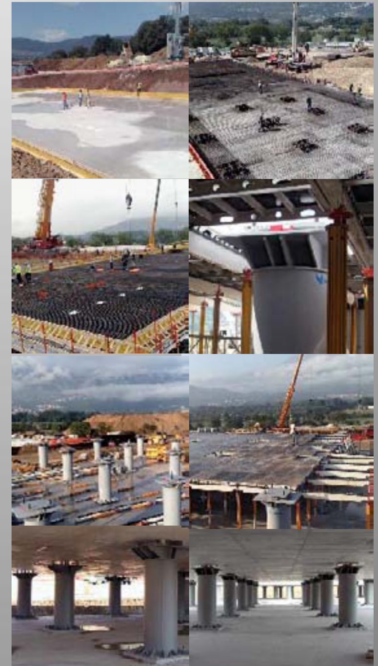
Projecte C.A.S.E. Procés construcció placa antisísmica
