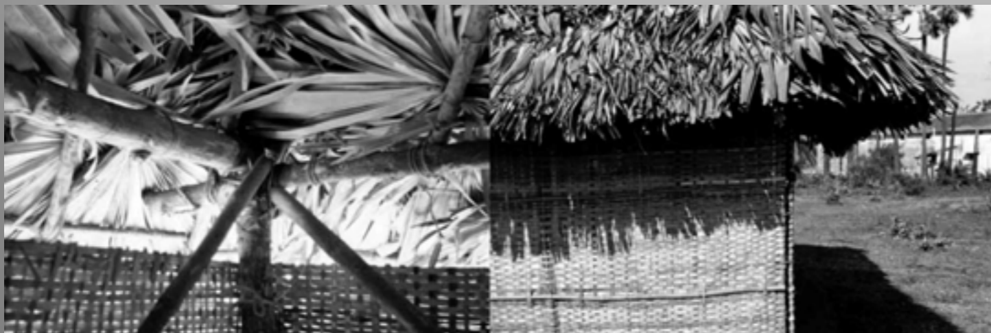
Detalls del model de casa construït per ensenyar tècniques constructives enfront dels ciclons
