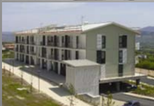
Projecte C.A.S.E. Estructura de formigó
