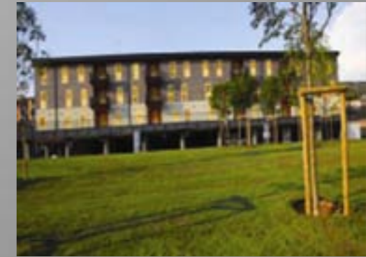
Projecte C.A.S.E. Estructura d'acer
