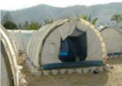
Tienda de fibras flexibles. Formación de suelo mediante sacos de arena para evitar inundaciones. Tienda Ferrino superficie útil 15m<sup>2</sup> y 42 kg de peso
